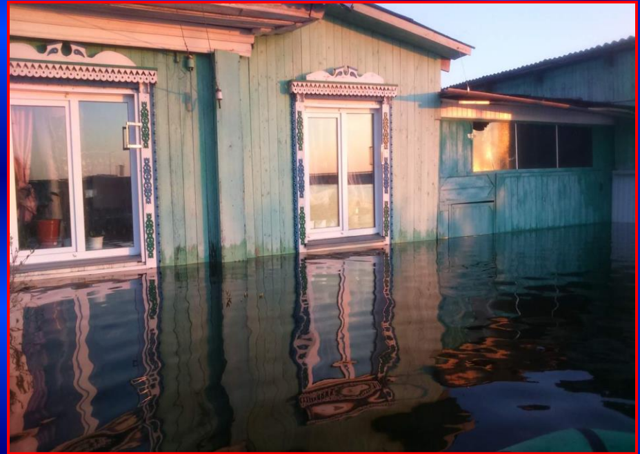
Вода по окна (г. Туринск)
